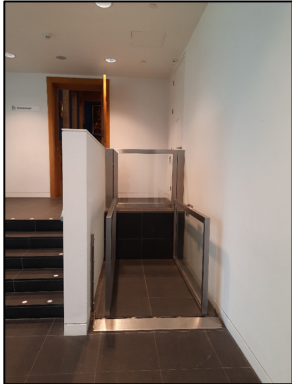
Lift naar de Statenzaal (rustruimte)
