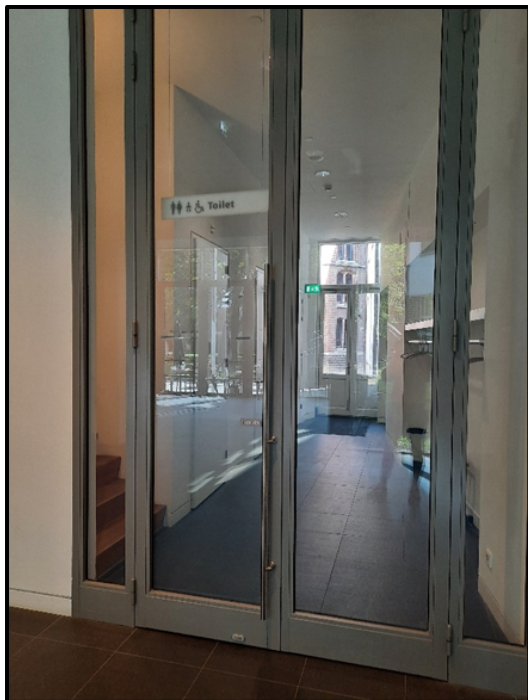
Deur naar de toiletten
