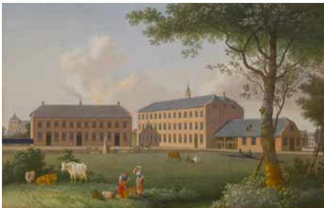
Josephus Augustus Knip (1777-1847) of Mattheus Derk Knip (1785-1845) Boven: Het Paradijs , deel van het fabriekscomplex van textielindustrie J.Th.M. Smits & Zn te Eindhoven Onder: Den Bouw , deel van het fabriekscomplex van textielindustrie J.Th.M. Smits & Zn te Eindhoven ca. 1832, gouache op papier, 56 x 87 cm Collectie Het Noordbrabants Museum, langdurig bruikleen Collectie Smits van Oyen, mogelijk gemaakt door Dimensys
